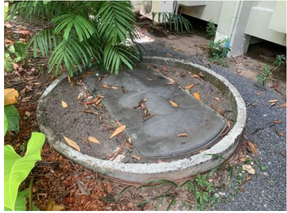
ภาพที่ 21 บ่อกรอง-กรองไร้อากาศ เพื่อรองรับน้ำเสียจากอาคารห้องพัก
